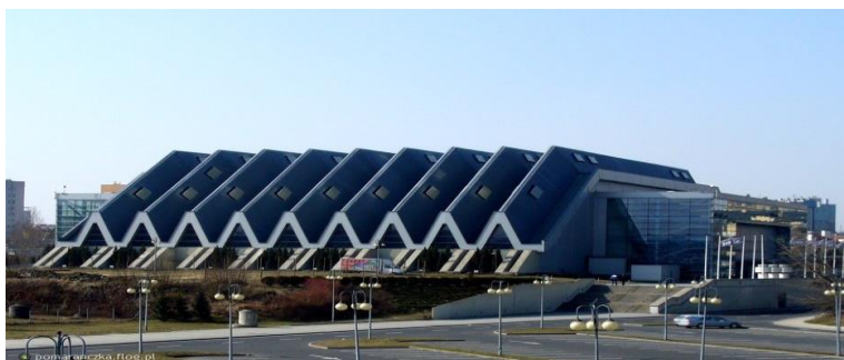
Sport Hall in Rzeszów, Podpromie Street 10
